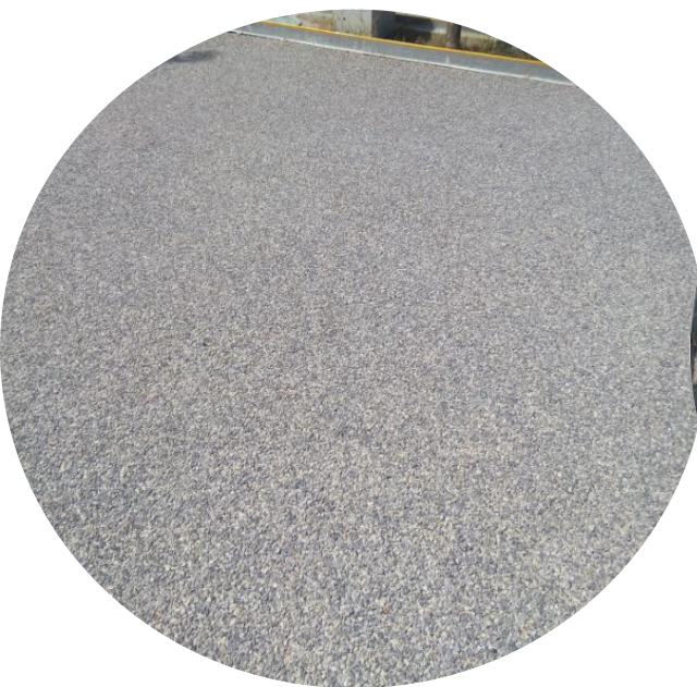
透水混凝土铺装
